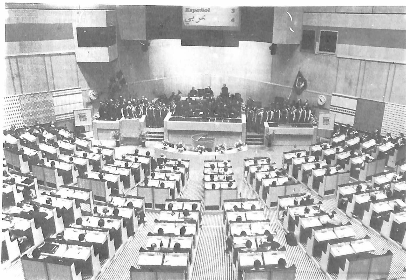
Vista general de la sala de conferencias durante la sesión inaugural.
