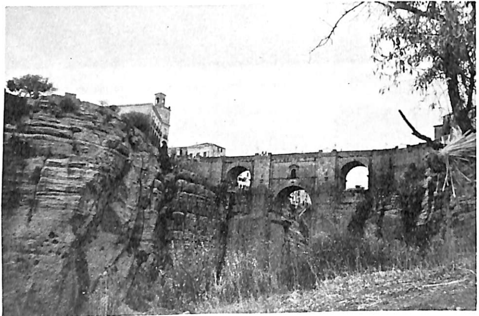
Ronda: the Puente Nuevo.
