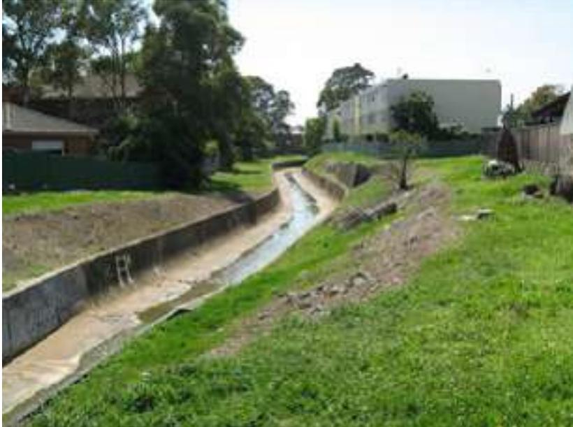
Drenaje pluvial de canal abierto
