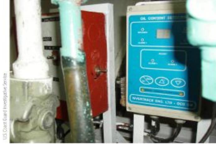
21. مفتاح التفاف جرى تركيبه لإسكات جهاز الإنذار الخاص بجهاز "رصد محتوى النفط" وتمكين "جهاز فصل المياه الزيتية" من مواصلة العمل حتى عندما يتخطى محتواه من النفط حدود (15 ppm).
