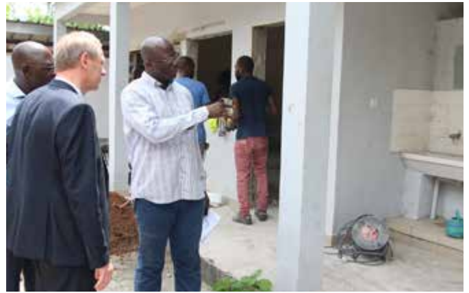
Visite des chantiers du Centre de traitement des informations Policières par Directeur pour le développement et de la Planification, 24 Février 2020, Abidjan (Côte d'Ivoire)
