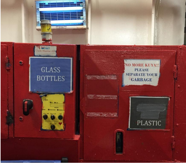
غرفة القمامة وآلة الكبس. المصدر: الهيئة الأسترالية للسلامة البحرية
